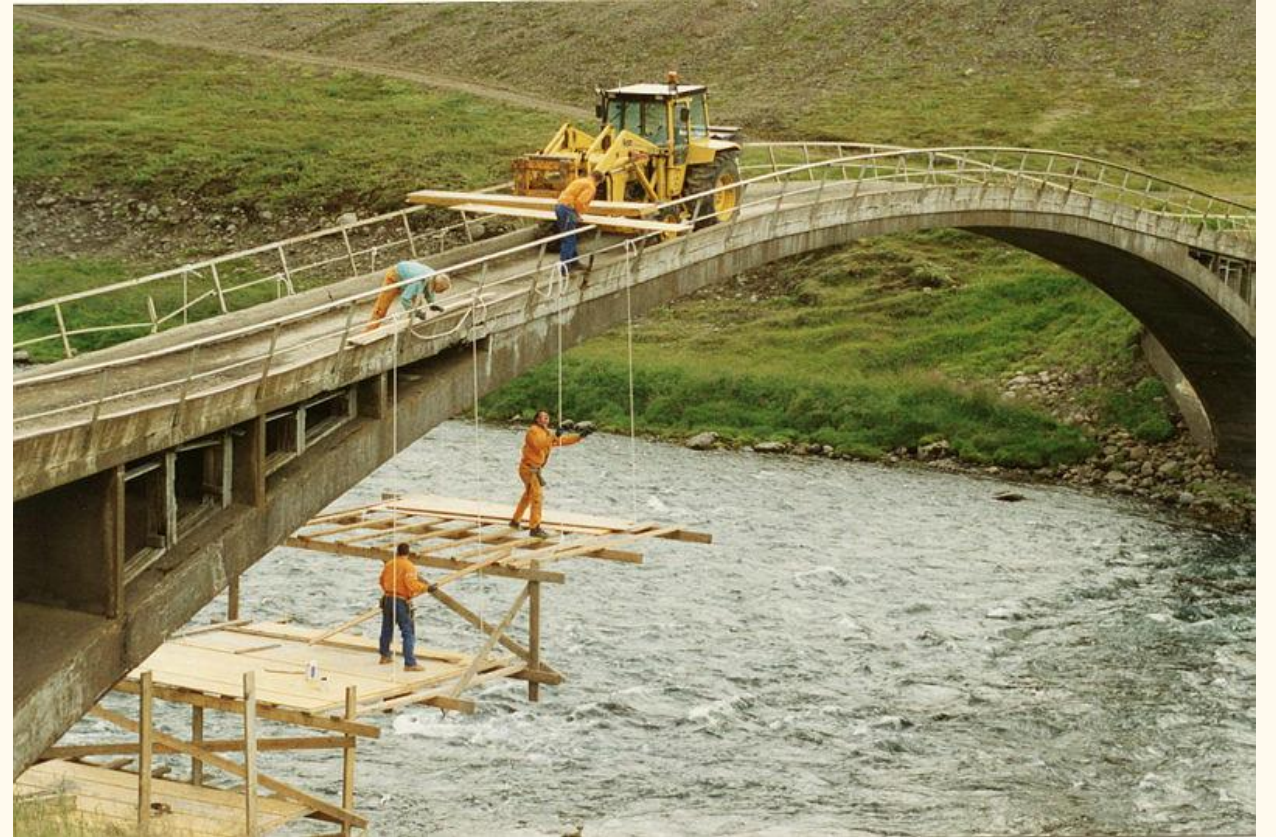
Fnjóskárbrúin í Vaglaskógi reist árið 1908 og var það fyrsta brú sem gerð var á Íslandi úr járnbentri steinsteypu. Endurgerð 1993-1994
